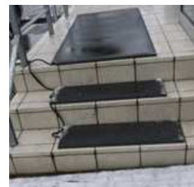
<ヒートマットの設置例>
